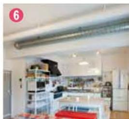
**6** **天井**：天井を撤去したので高さが生まれ、風通しも良くなりました。天井裏にあったダクト配管は塗装して「見える」仕様に。
